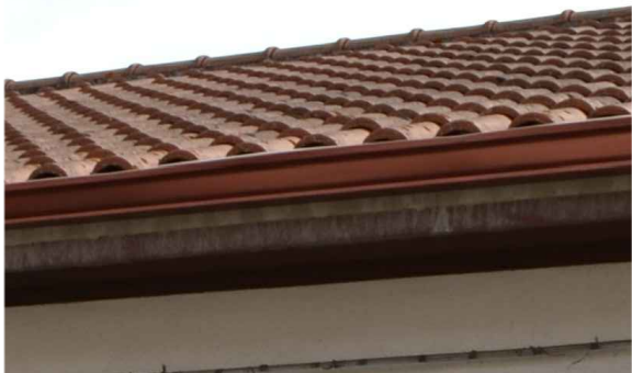
B.2 Cornice aggettante con modanature, muretto d'attico e smaltimento delle acque con canale di raccolta e discendente frontale
