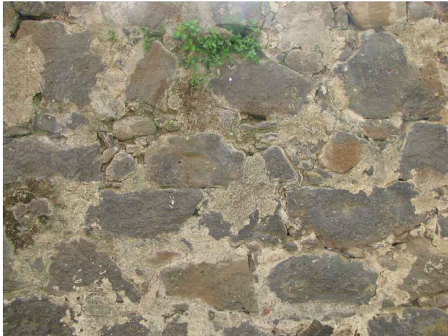
A.5 Tessitura muraria in conci squadradi di basalto quasi totalmente coperti con calce
