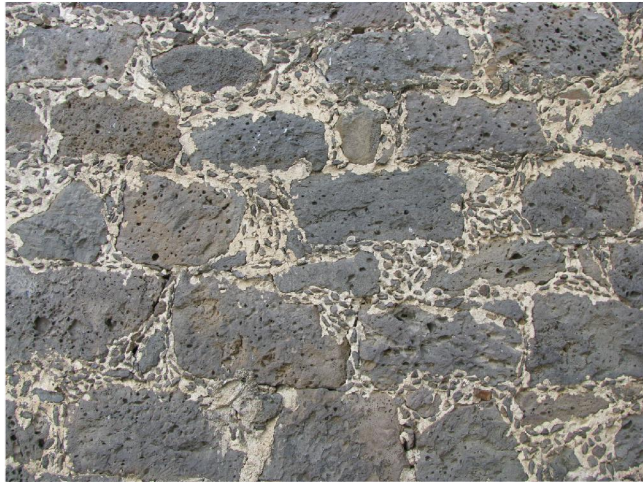
A.6 Tessitura muraria in conci squadradi di basalto disposti secondo corsi sub-orizzontali allettati con malta di calce e con fughe decorate con l'innesto di piccoli ciottoli.
