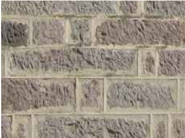
A.8 Tessitura muraria in conci squadradi di basalto disposti secondo corsi sub-orizzontali
